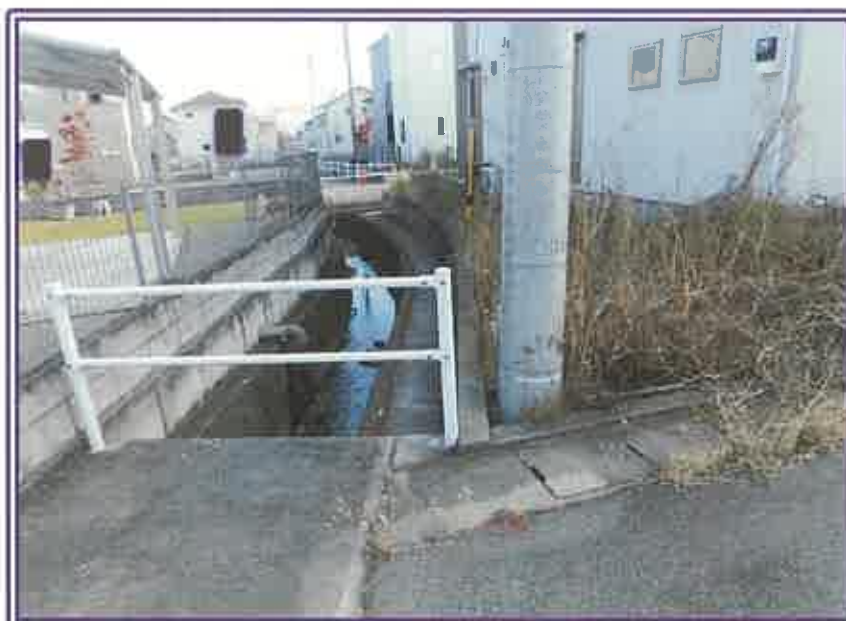
隣接水路の状況
