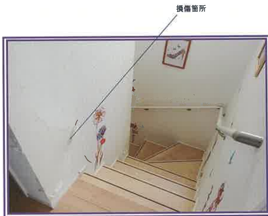
2階から、階段方向を撮影したもの
