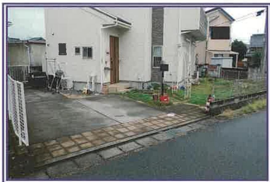
駐車スペース及びその周辺を撮影したもの
