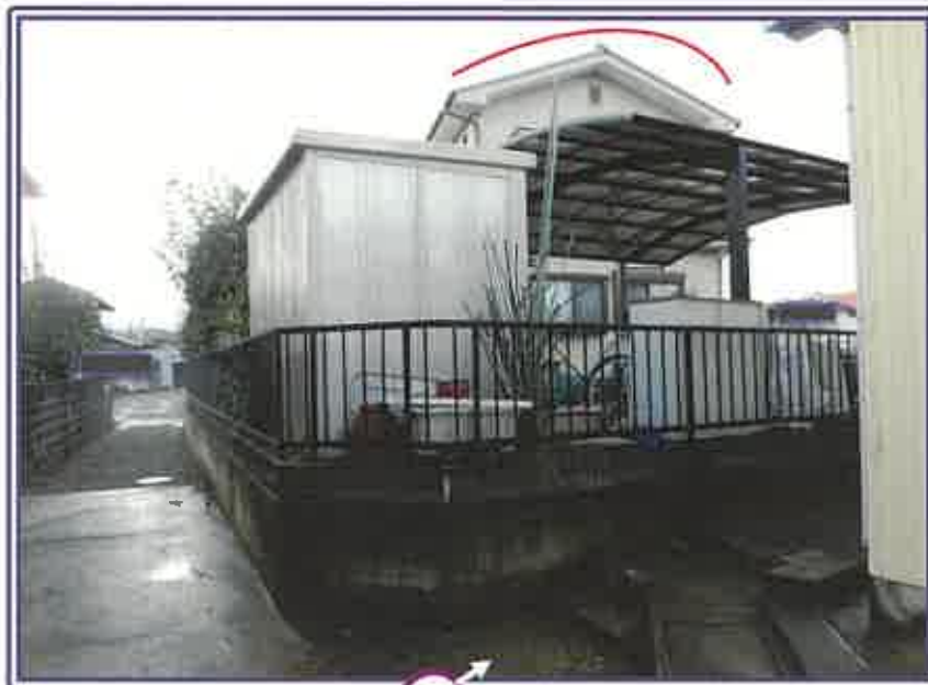
南東角境界付近の状況
