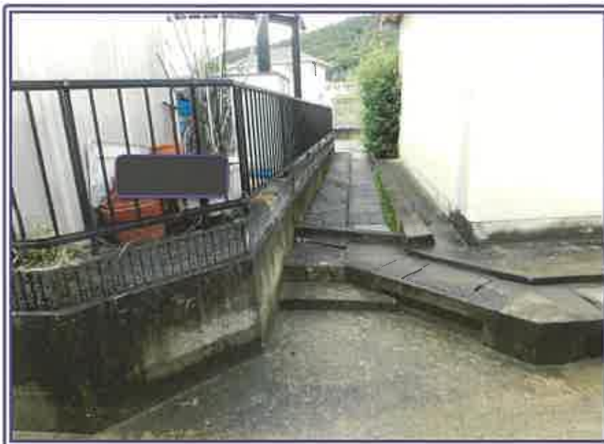
隣接水路の状況
