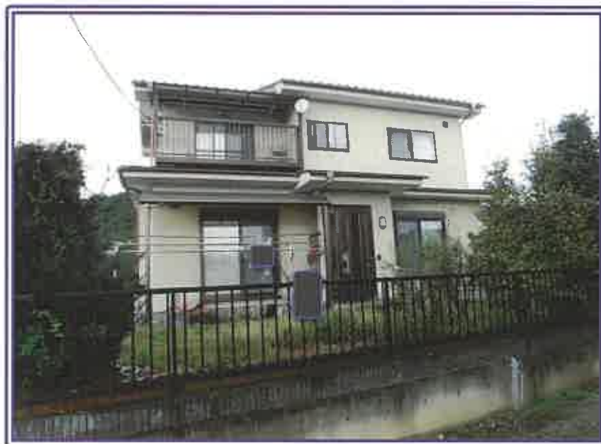
玄関側（裏道側）近景
