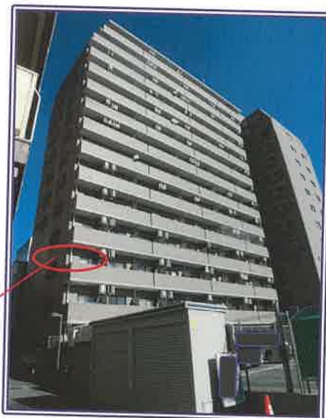
売却物件側の近景
