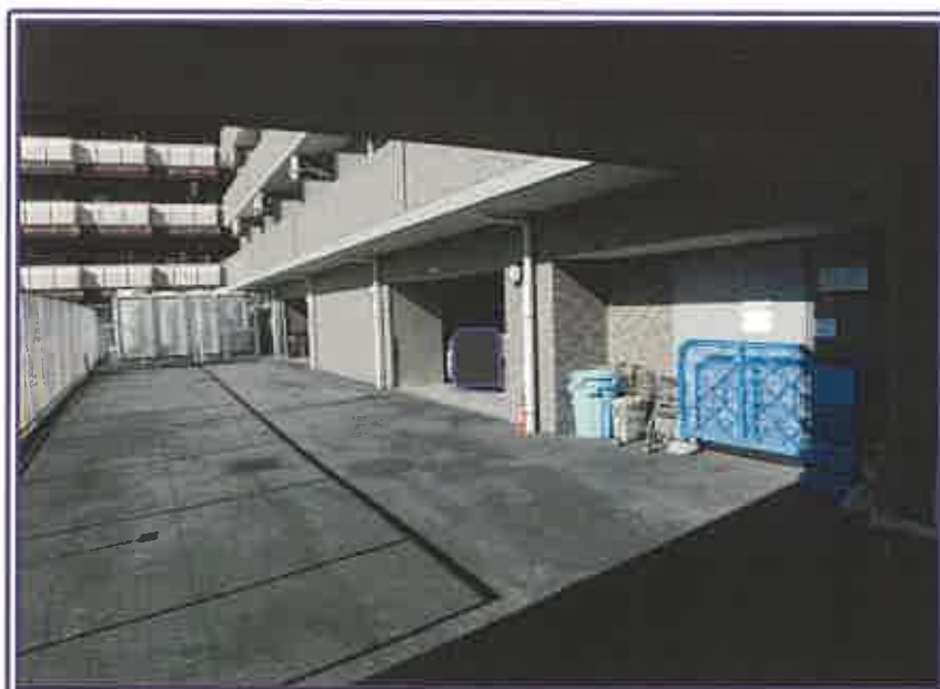
敷地内の状況
