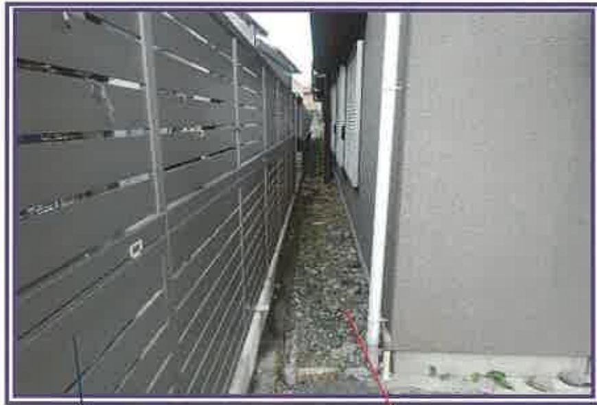
北側隣地(2541-8)上の フェンス
