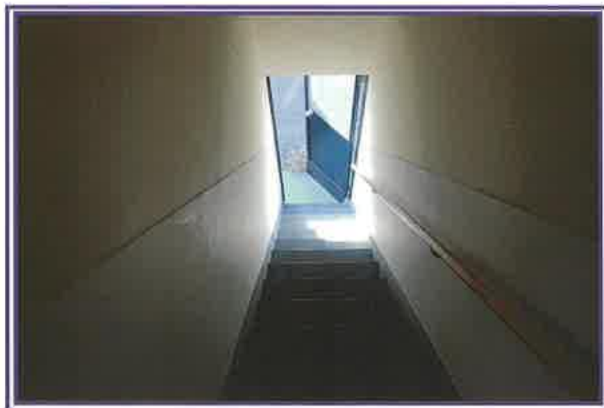
本件建物西側階段を、2階から撮影したもの
