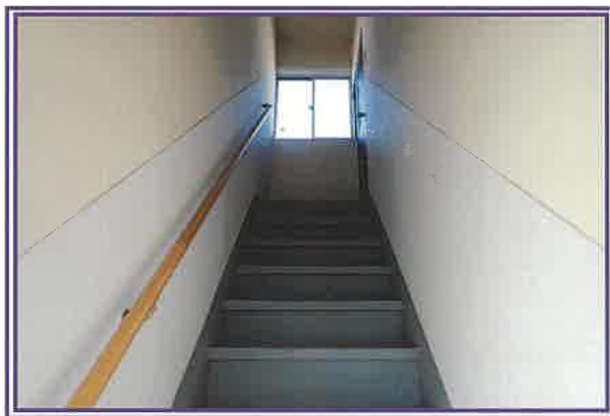
本件建物西側階段を、1階から撮影したもの
