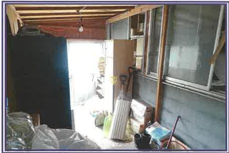
入口通路部分 (物件4主である建物)
