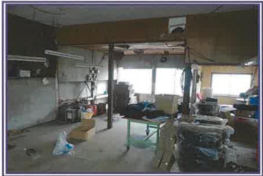
作業所(北側) (物件4主である建物)
