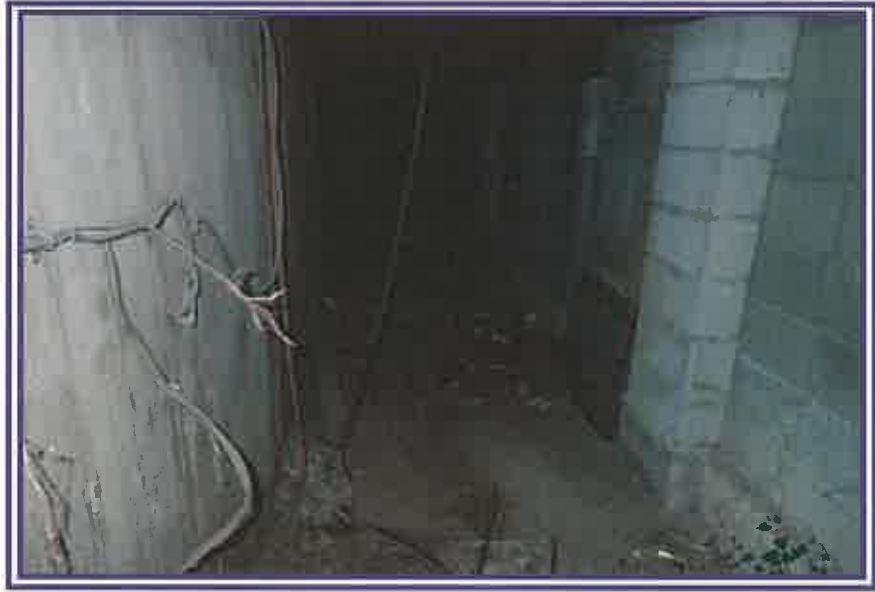
通路部分 (高床式構築物)
