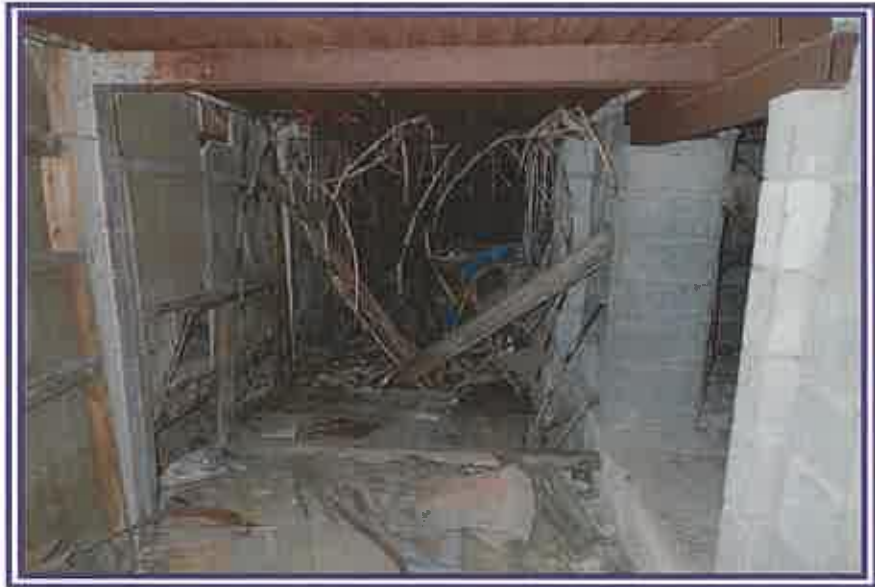
通路部分 (高床式構築物)
