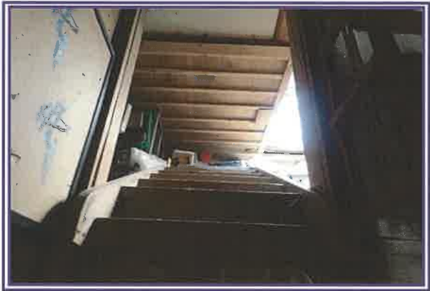
2階から、階段方向を撮影したもの(物件2主である建物)
