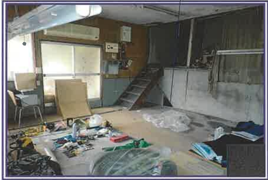
作業所(北側) (物件4主である建物)
