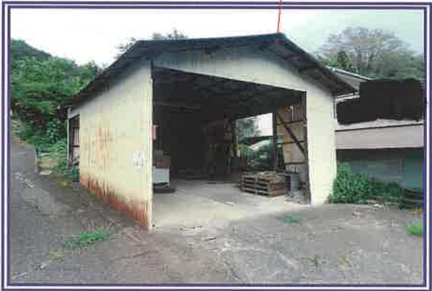
物件4附属建物 符号1(車庫)
