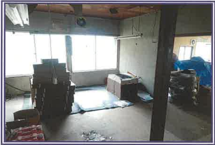
作業所(北側) (物件4主である建物)
