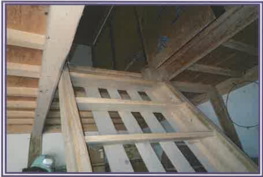
1階から、階段方向を撮影したもの(物件2主である建物)
