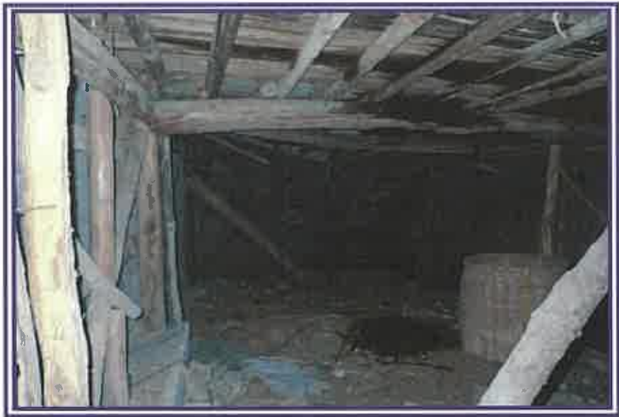
保管庫 (高床式構築物)
