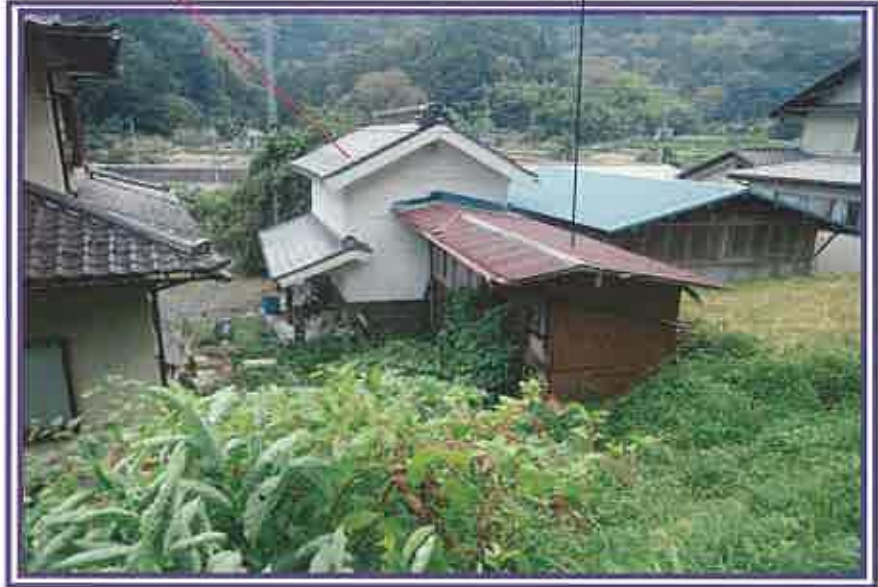
物件2未登記 附属建物(倉庫)
