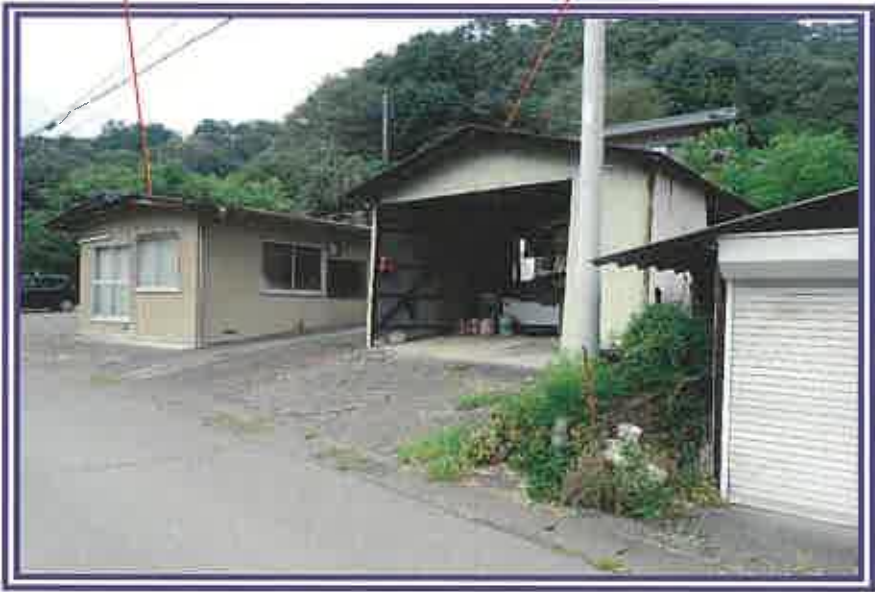
物件4附属建物 符号1(車庫)
