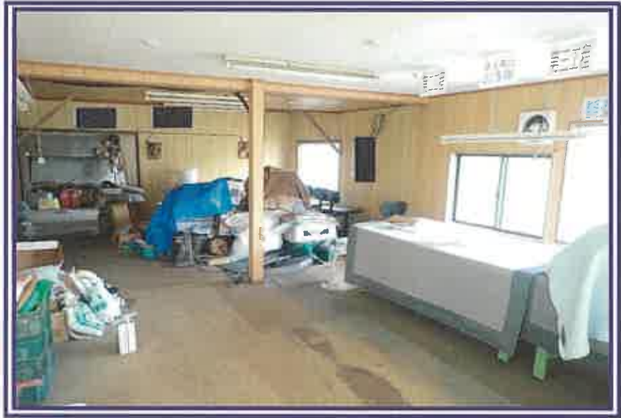
作業所(南側) (物件4主である建物)
