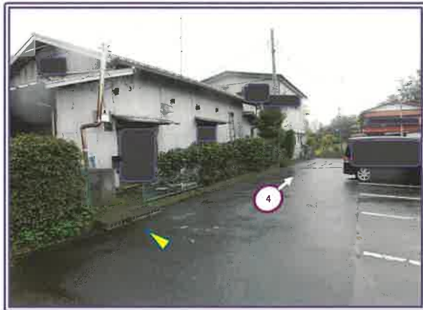
隣宅に設けられた出入口の状況
