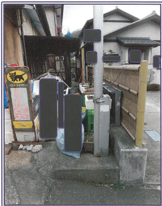
南西角境界付近の状況
