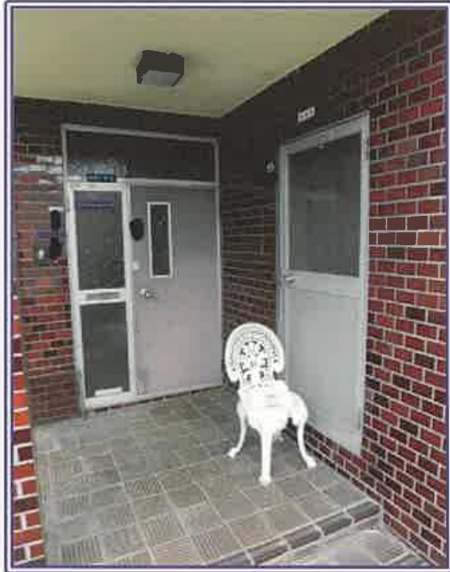
玄関ポーチ (左側が居宅用ドア・右側が事務所用ドア)
