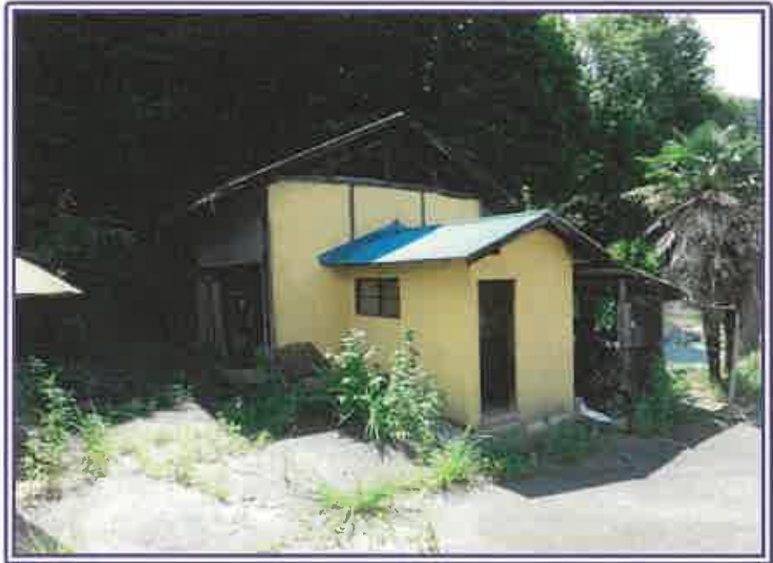
目的外建物1・附属建物2（便所・物置）の庭側近景
