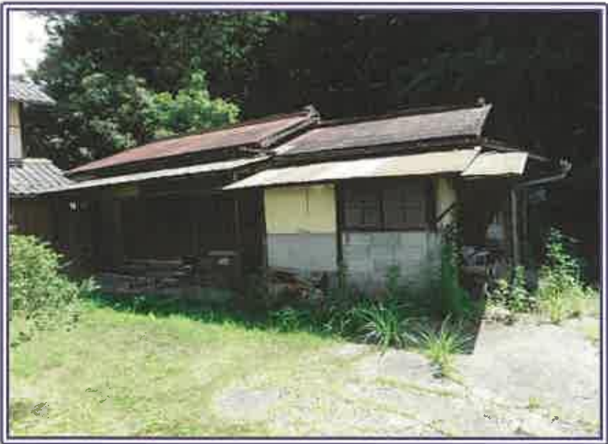
目的外建物1・附属建物1（物置）の庭側近景
