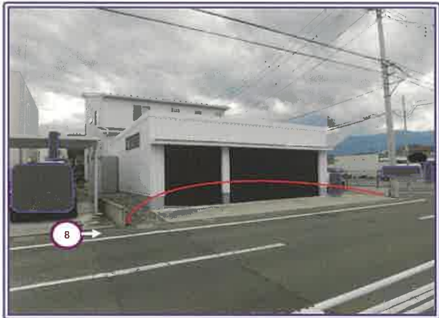
本件物件の本道側近景（手前が車庫・奥が居宅 赤線は敷地）
