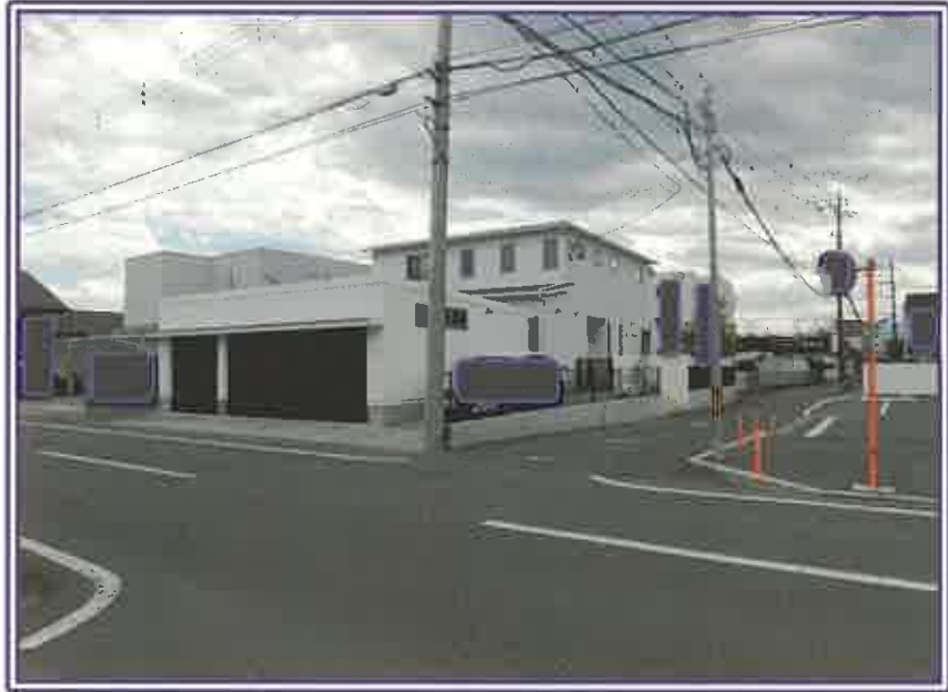
本件物件の本道側全景
