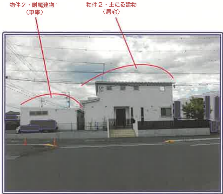
本件物件の側道側全景（側道の手前はコンビニエンスストアの敷地）
