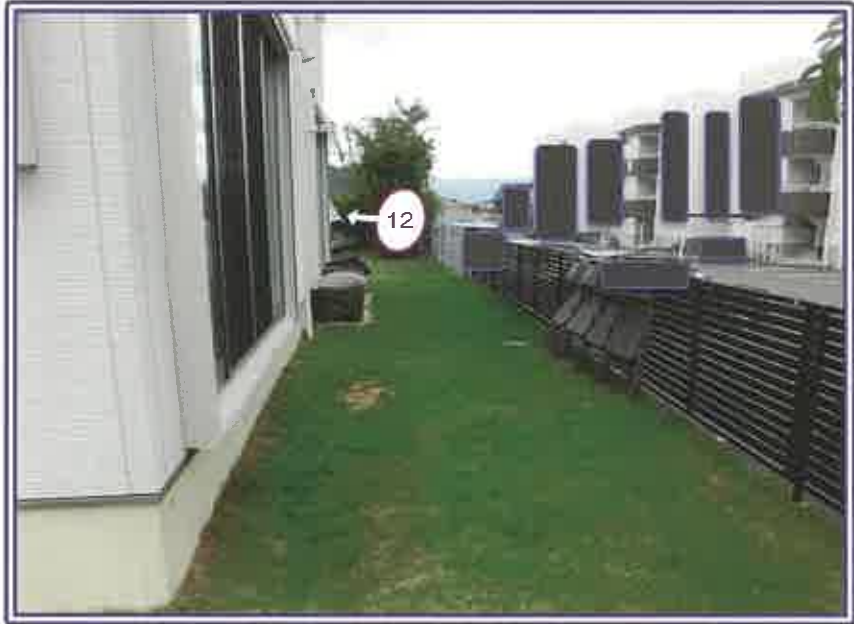
裏側敷地内の状況
