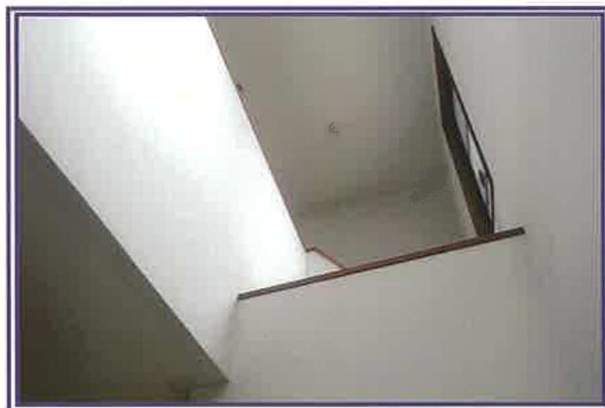
玄関から、吹抜・階段方向を撮影したもの
