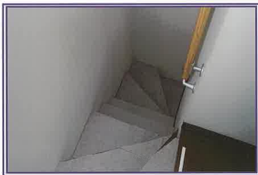
2階から、階段方向を撮影したもの
