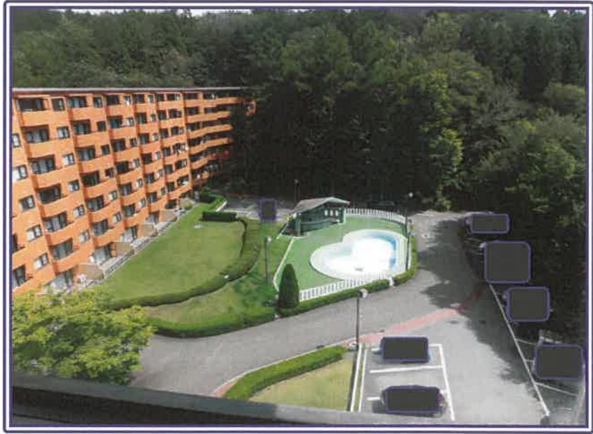
マンション敷地内の状況（上空写真）
