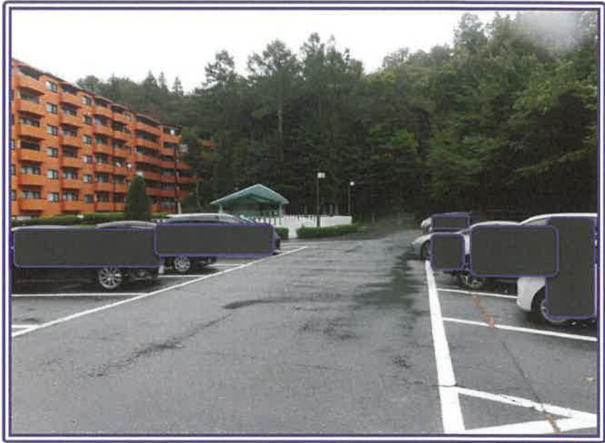
マンション敷地内（駐車場）の状況
