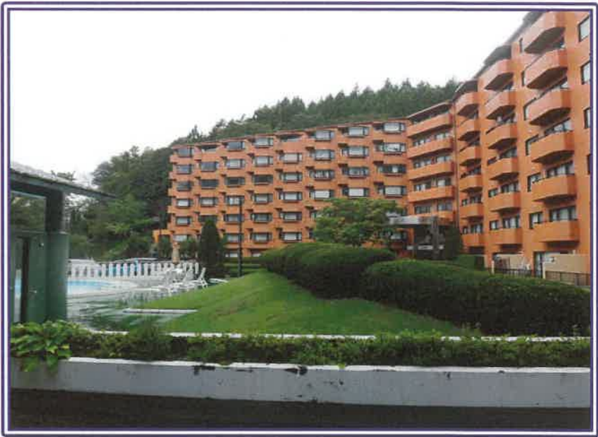
マンション敷地内の状況
