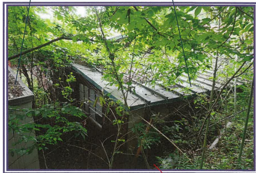
物件4(宅地)付近
