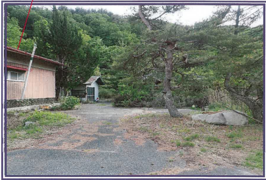
道路から、本物件敷地方向を撮影したもの
