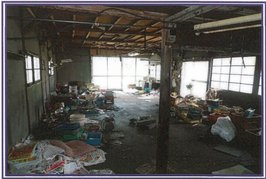
倉庫の内部を撮影したもの(物件8の未登記附属建物1)
