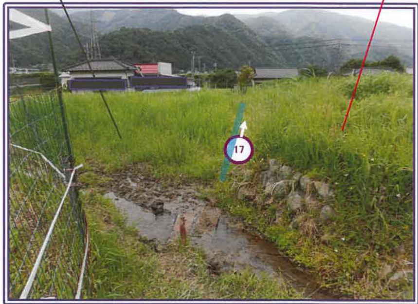
本件物件が北側で接する公園上の水路（水色線）付近の状況
