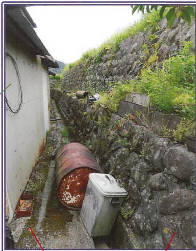
目的外建物1 (居宅)
