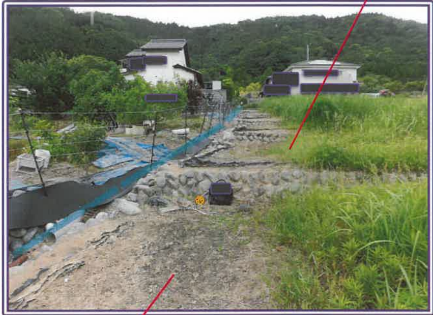
本件物件が南側で接する 公図上の水路（水色線）付近の状況
