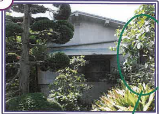
物件5の建物（居宅・物置）の北東側近景
