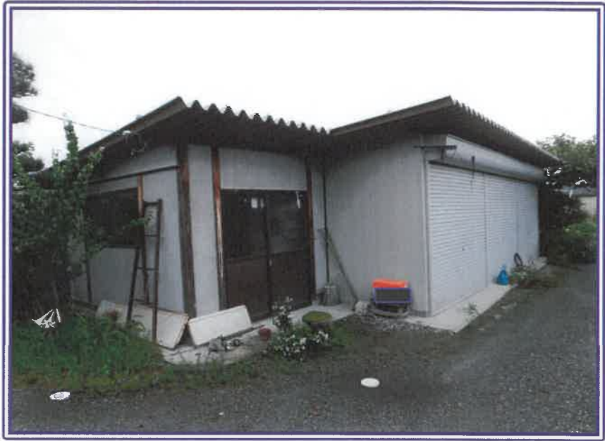
物件4・附属建物（車庫・物置）の近景
