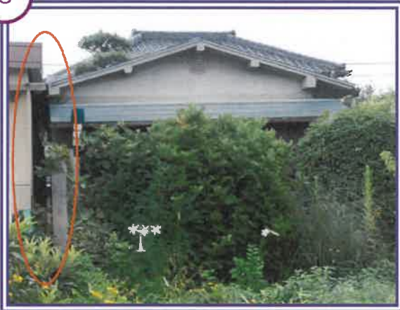
物件5の建物（居宅・物置）の南西側近景
