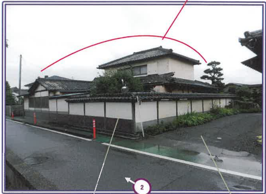
前面道路側の外景
