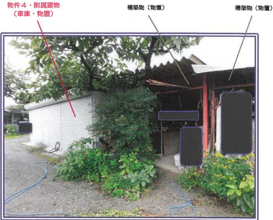
附属建物（車庫・物置）と附属構築物（物置）の近景
