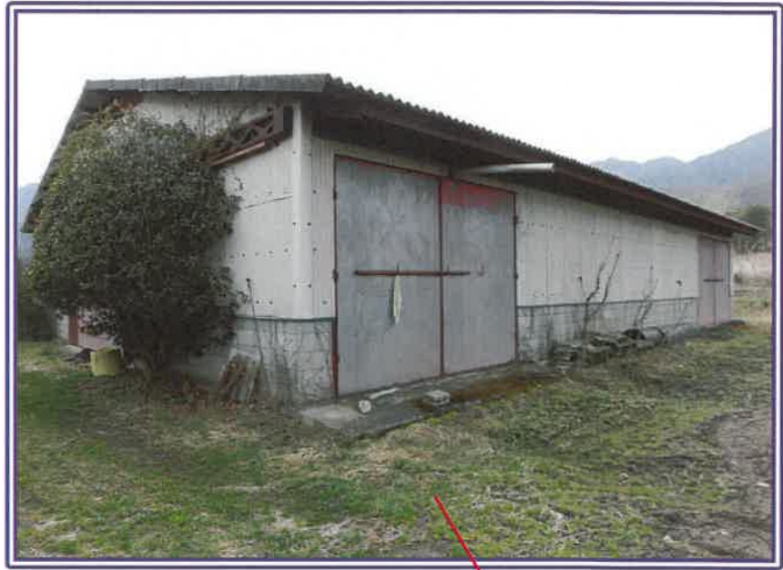
物件11 (宅地部分)
