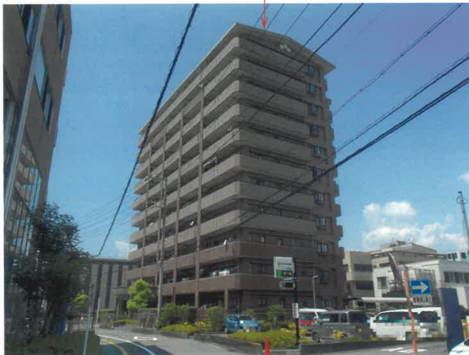
物件 1 の存する建物 1 棟
