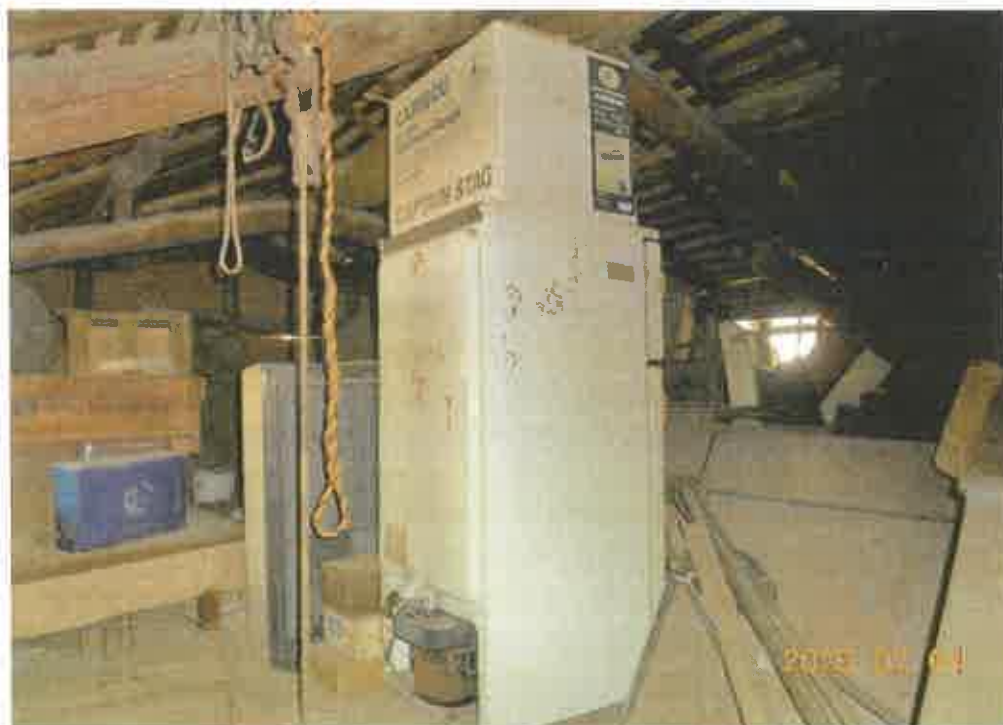
写真 2 2 本件建物の附属建物符号 1 の屋根裏部分（撮影位置の図示は省略）
