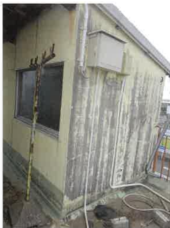
(14) 屋上に存在する北側塔屋 (構築物)
