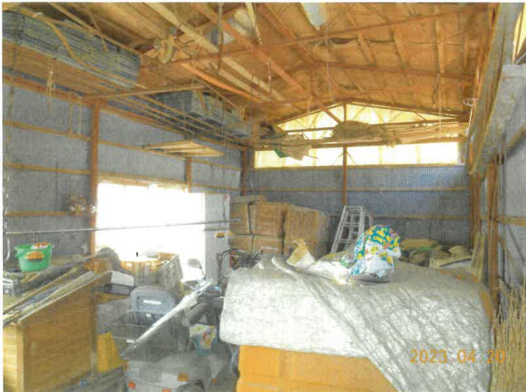
写真48 物件6の未登記附属建物（倉庫）内
