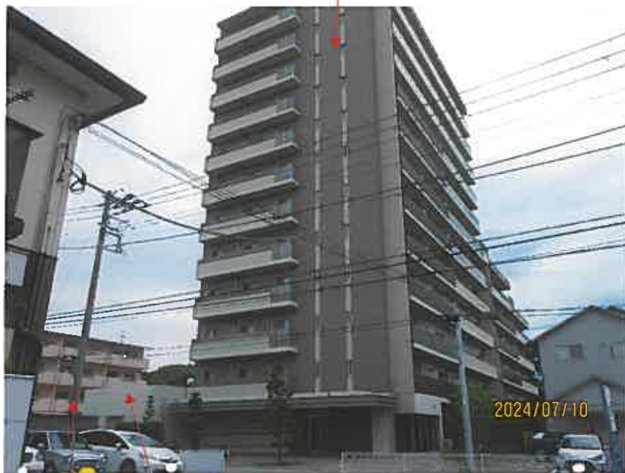
電柱 防災倉庫
