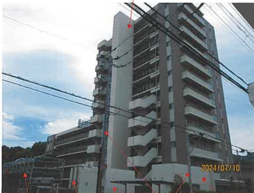
機械式駐車場 受水槽 機械室 電柱 防災倉庫
