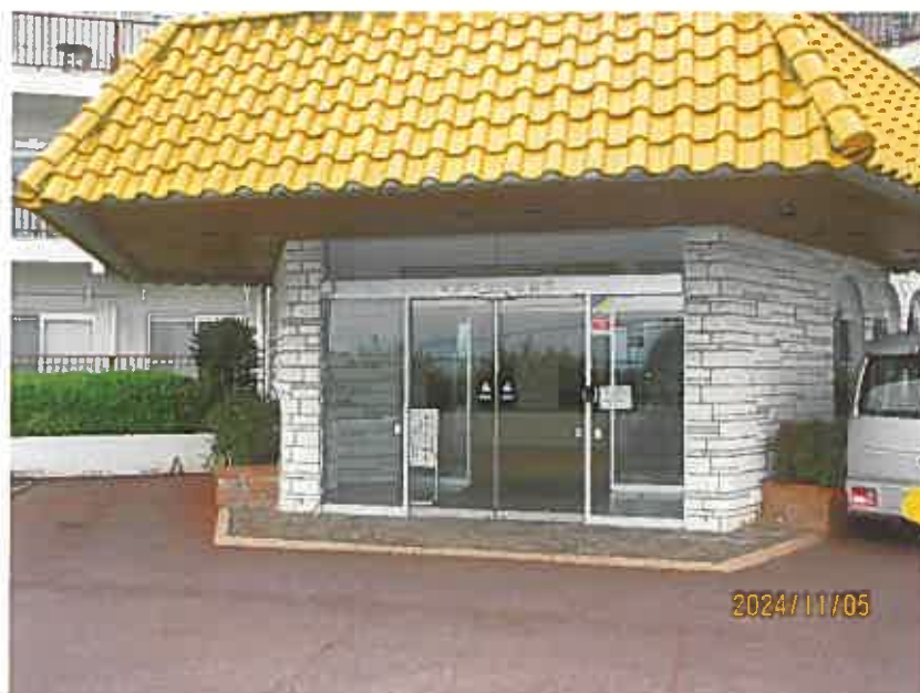
写真 4 本件マンション出入口
