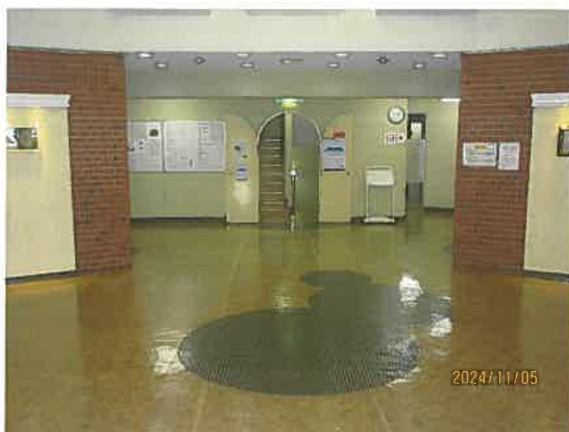
写真6 本件マンションエントランス②
