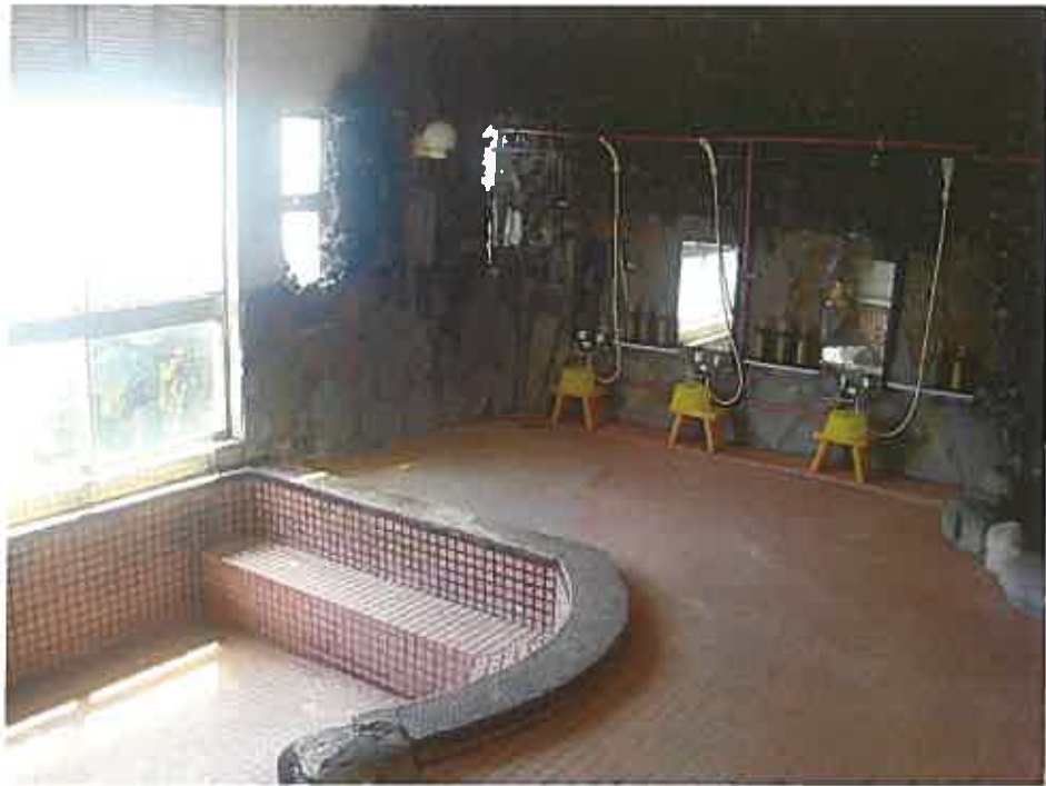
建物内の状況
