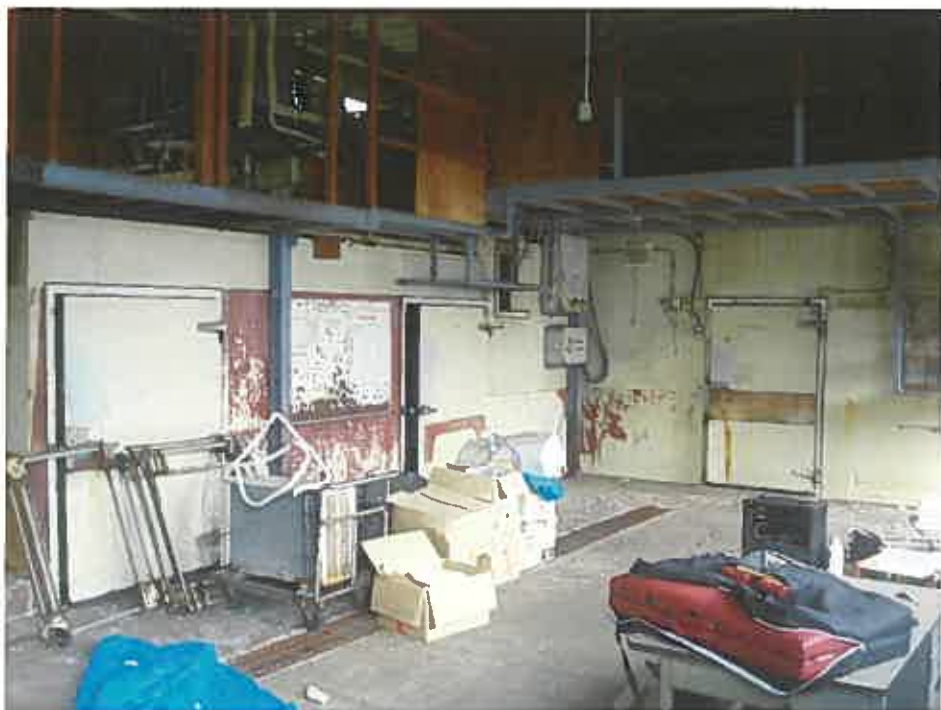
建物内の状況
