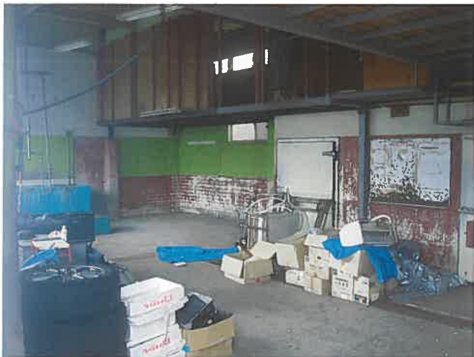
建物内の状況
