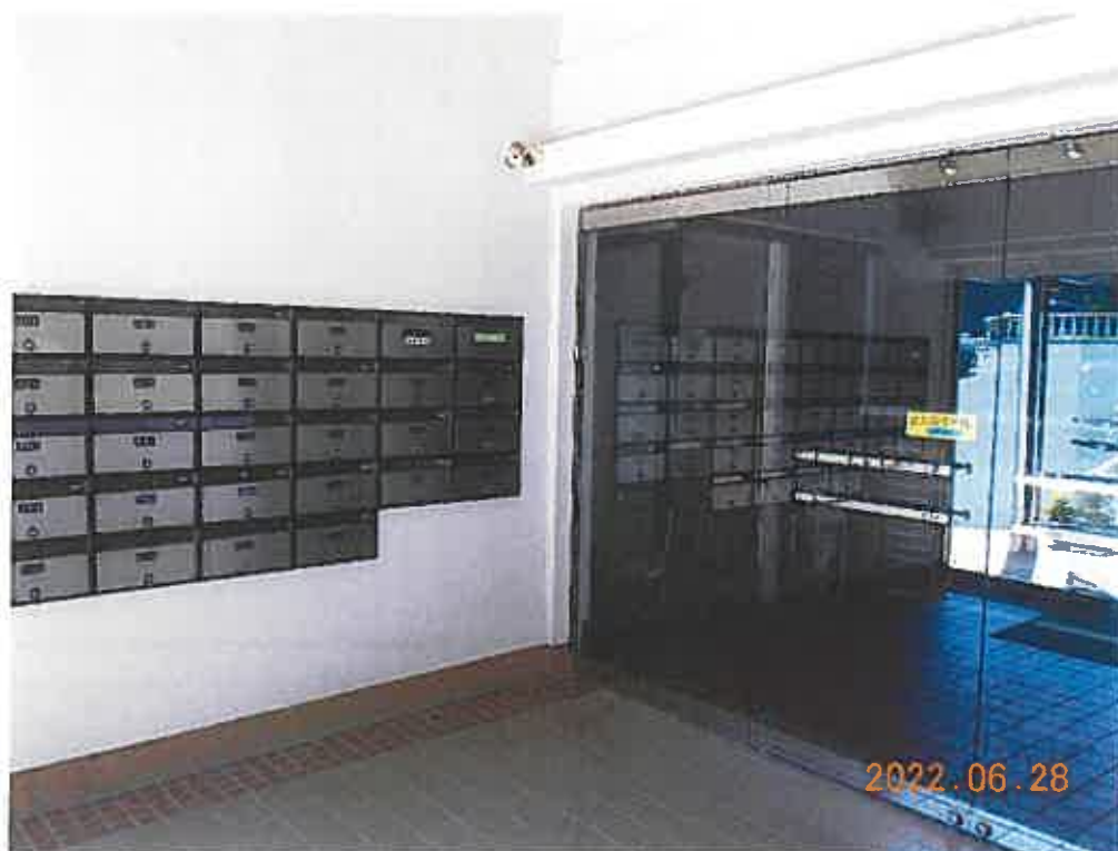
写真8 本件マンション2階エントランスホール（撮影位置の図示は省略）
