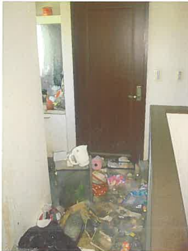
建物内の状況（物件 6）
