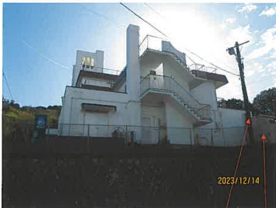
電柱 変電設備
