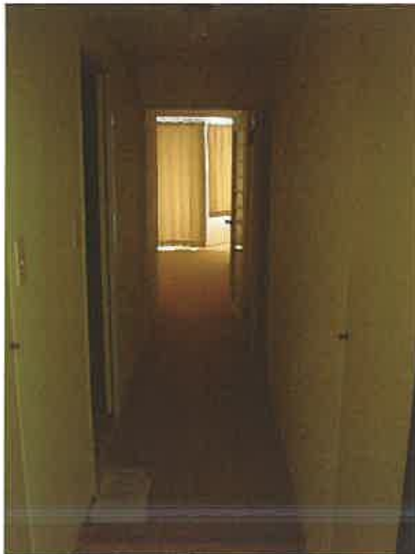
本件建物内の状況
