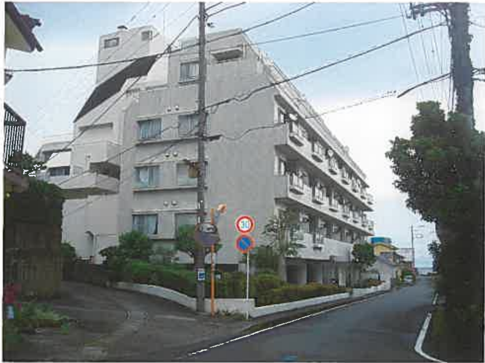
本件建物を含む一棟建物
