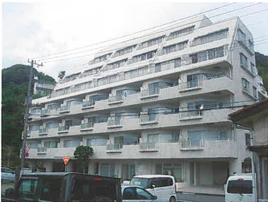
本件建物を含む一棟建物
