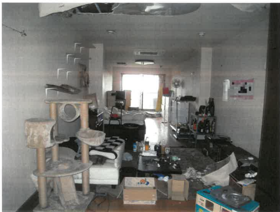
建物内の状況
