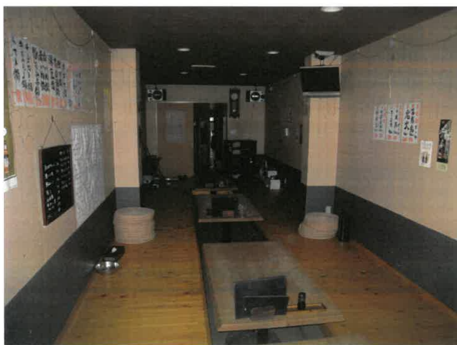
建物内の状況
