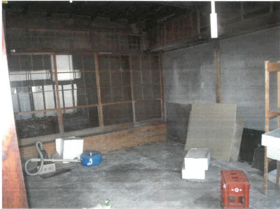
建物内の状況
