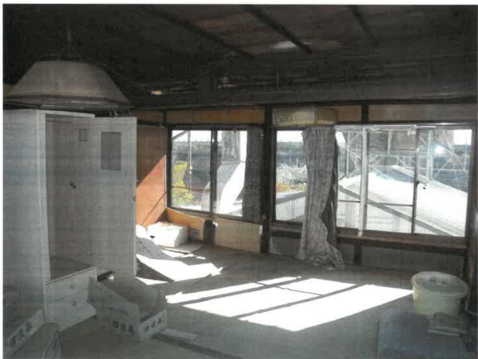
建物内の状況
