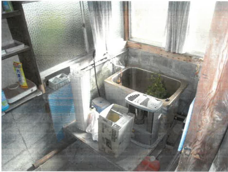
建物内の状況
