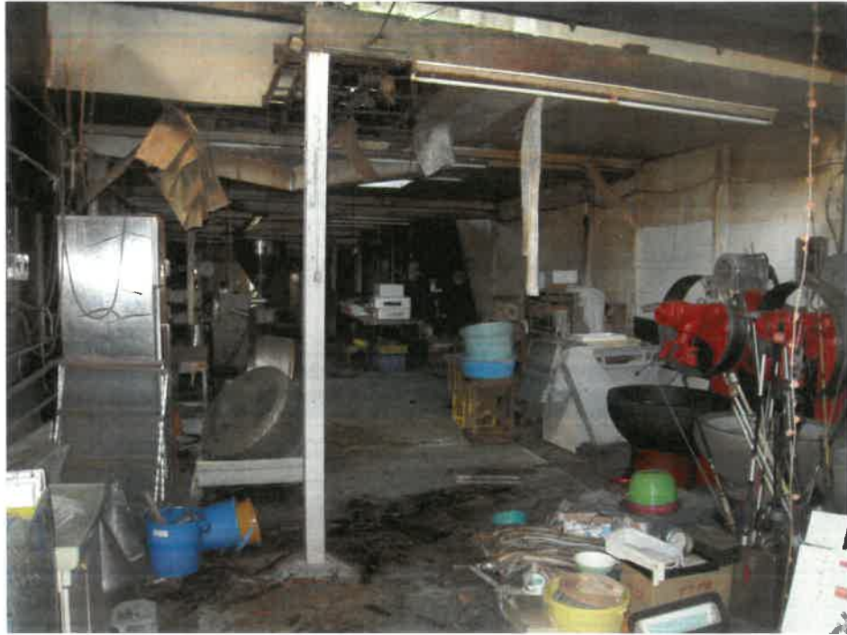
建物内の状況
