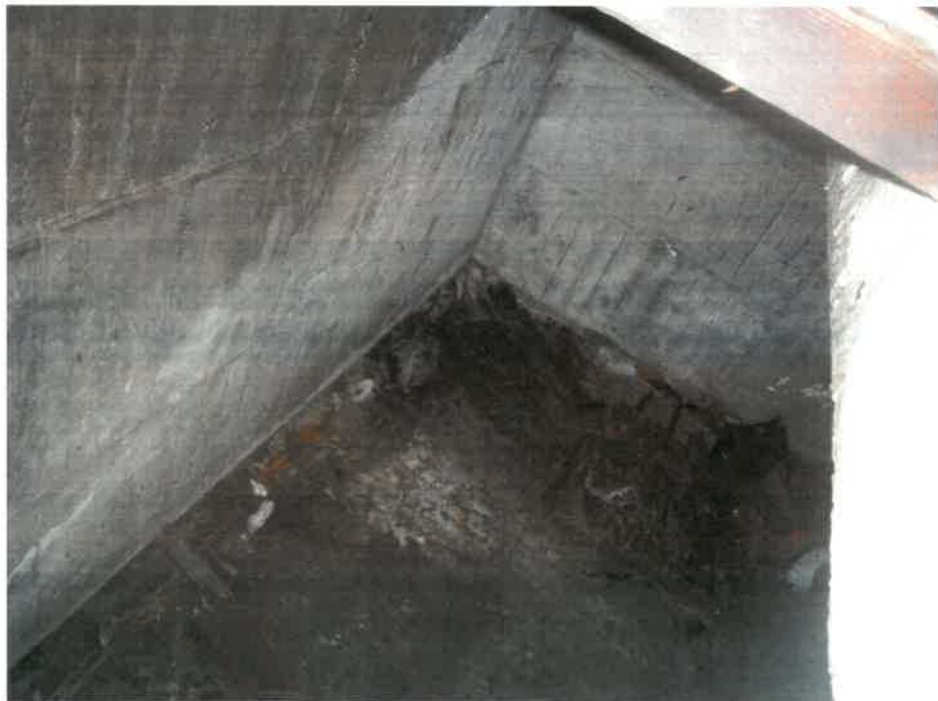
建物内の状況（地下収納）
