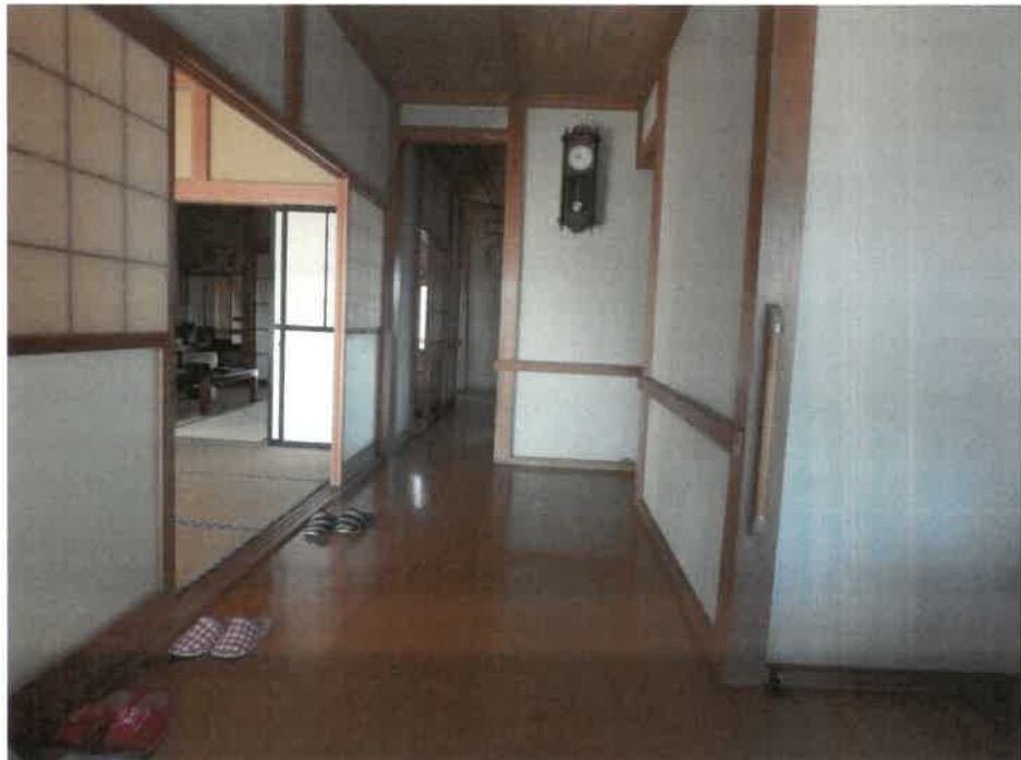
建物内の状況
