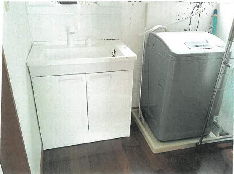
物件3 1階 脱衣洗面室の状況
