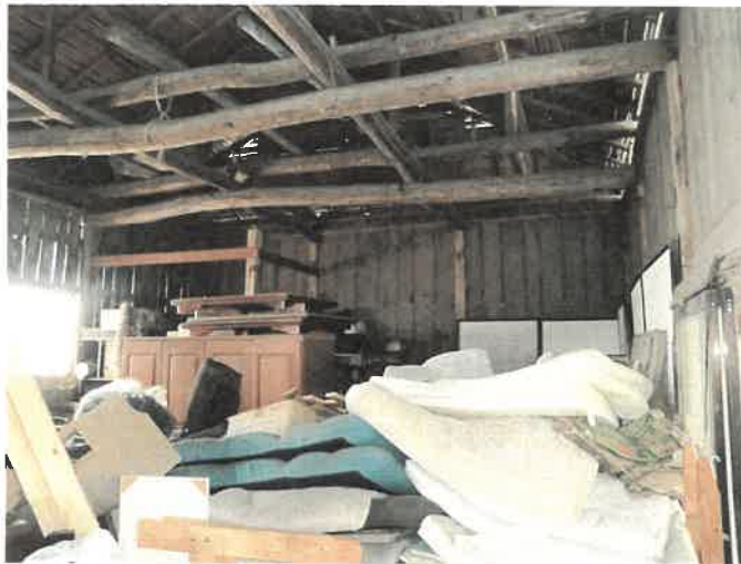
物件5主である建物 納屋の状況 ⑳
