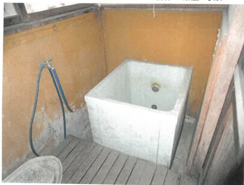
物件4 浴室の状況
