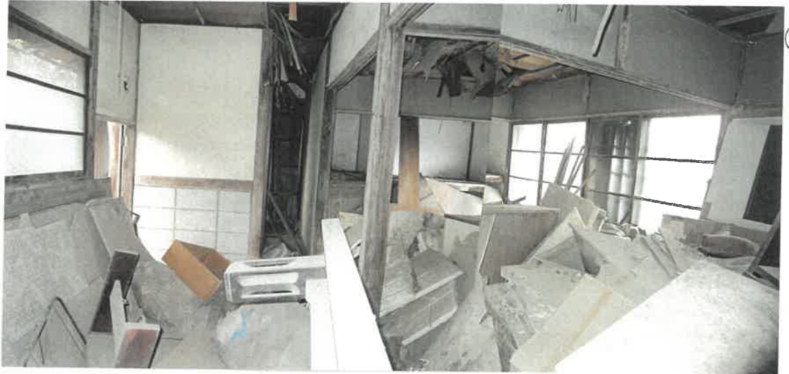
物件9 屋内の状況
