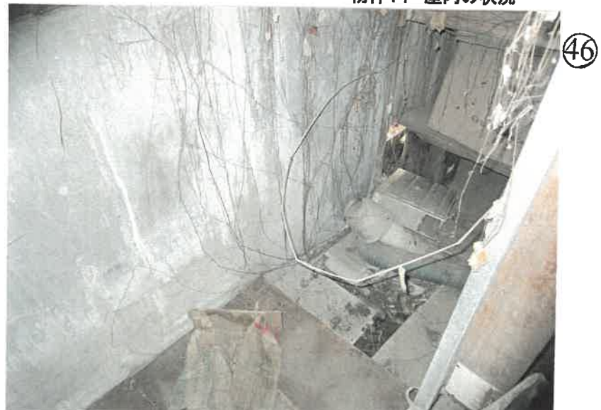
物件11 屋内の状況
