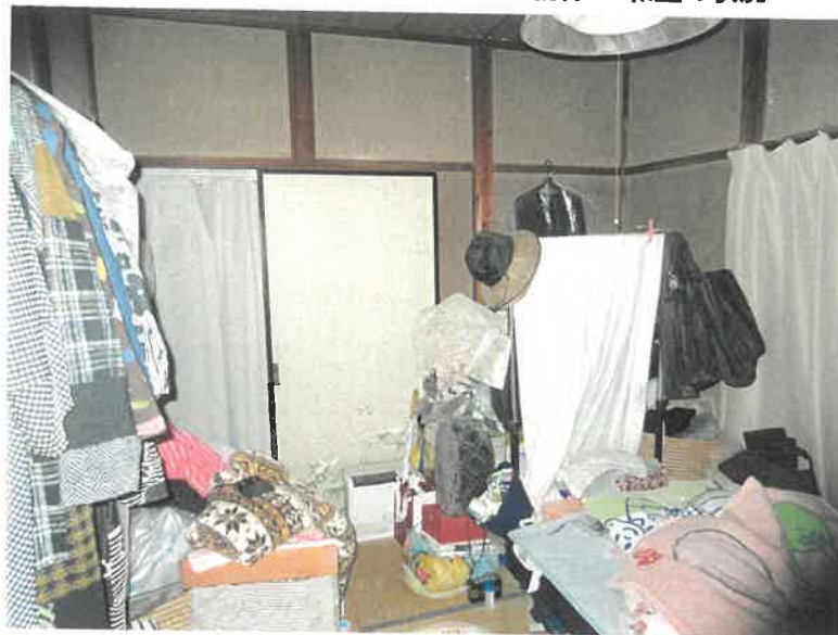
物件7 和室の状況
