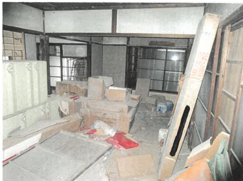
物件6 屋内の状況
