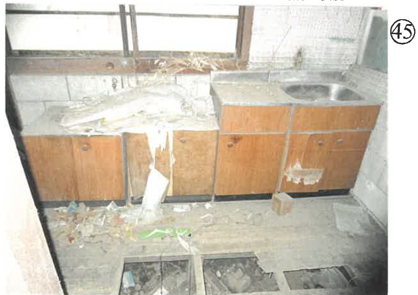
物件11 台所の状況
