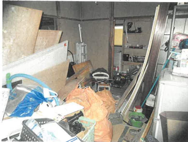
物件10 和室の状況
