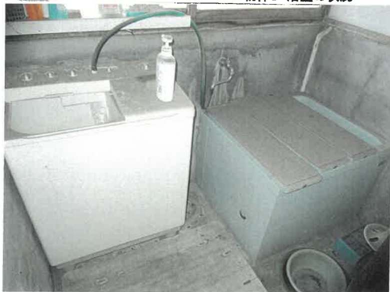
物件3 浴室の状況
