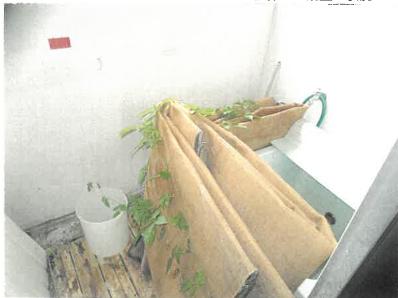
物件10 浴室の状況
