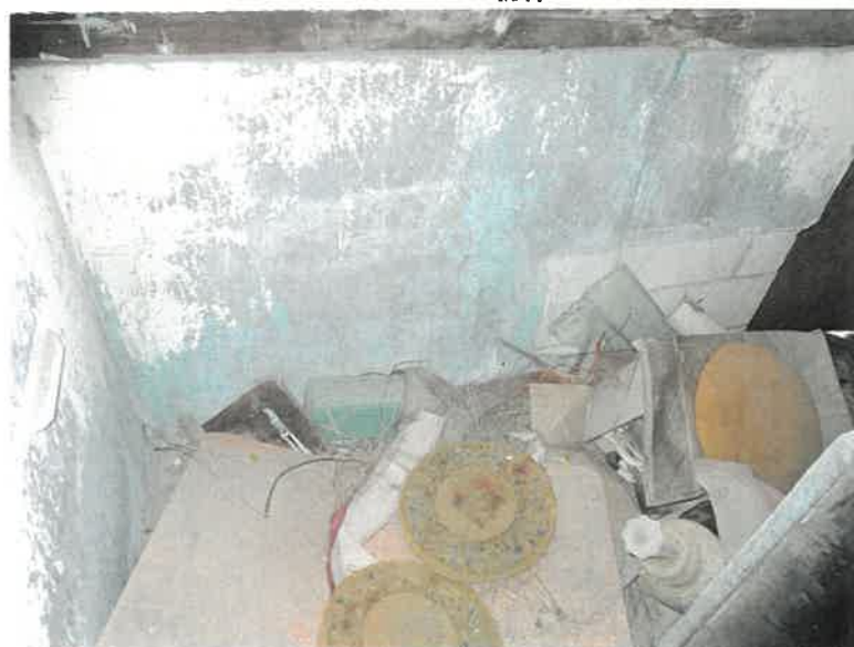
物件5 屋内の状況
