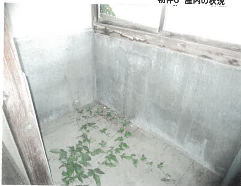
物件8 屋内の状況
