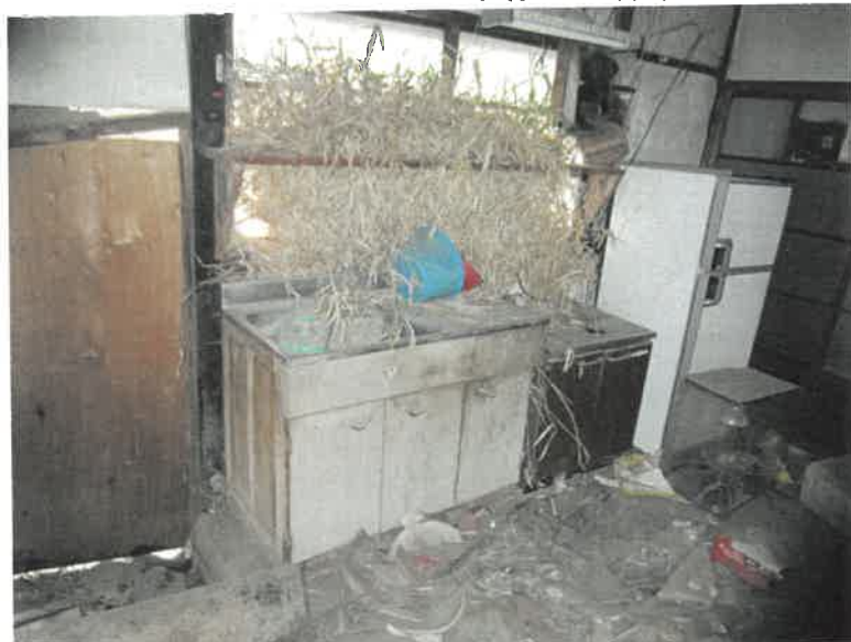
物件5 台所の状況
