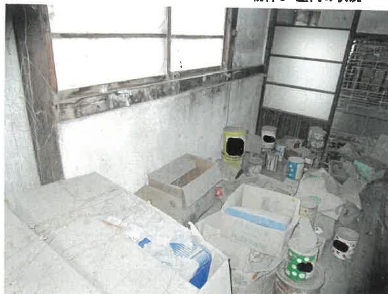
物件6 屋内の状況
