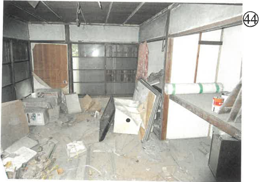
物件11 和室の状況
