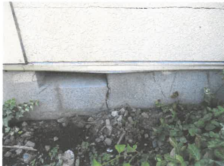
写真9 (建物基礎部分ひび割れ箇所)
