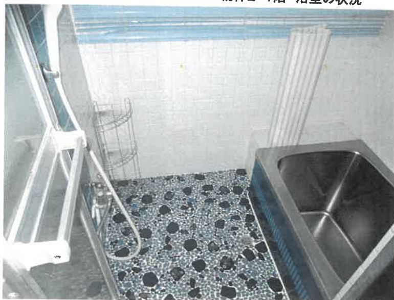
物件2 1階 浴室の状況
