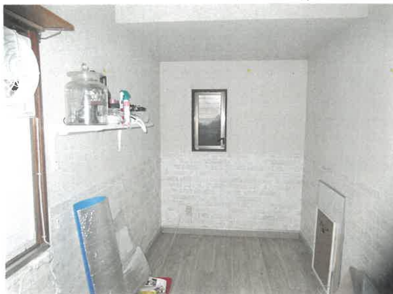
物件2 1階 洋室の状況
