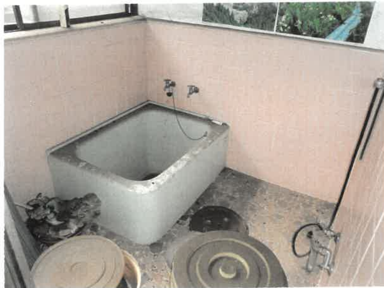
物件5 1階 浴室の状況
