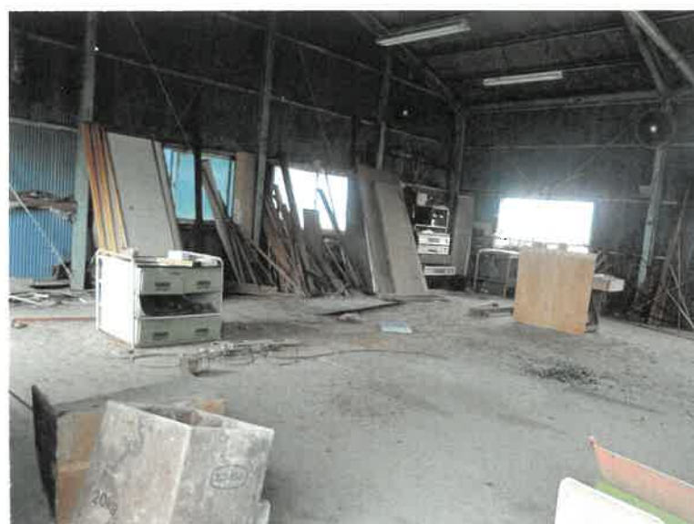
物件6主である建物 作業所の状況
