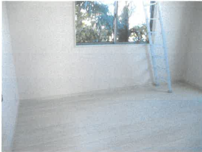
写 真 8 (2階南東側洋室)
