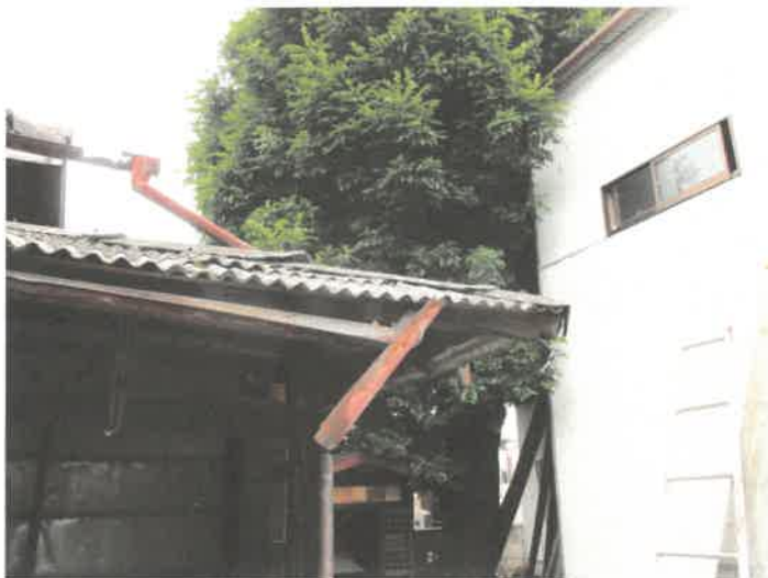
写 真 8 (物件2 附属建物符号2 の1階南側部分)
