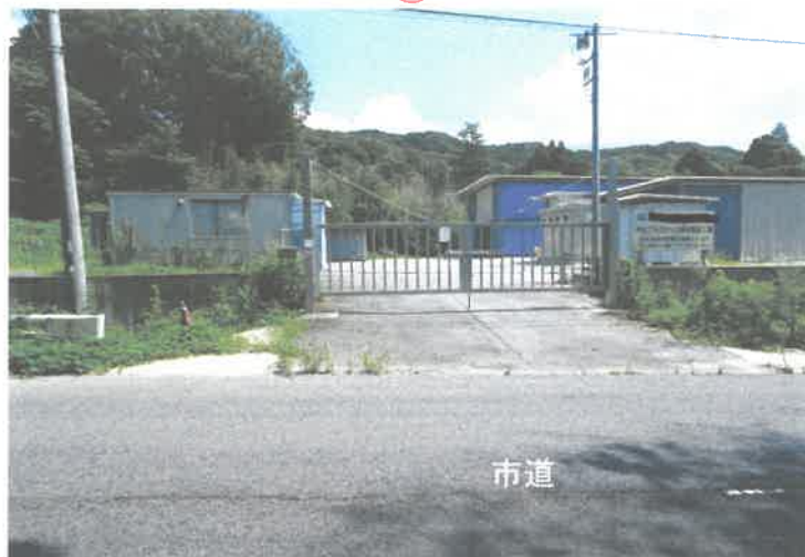
通路(橋)の状況
