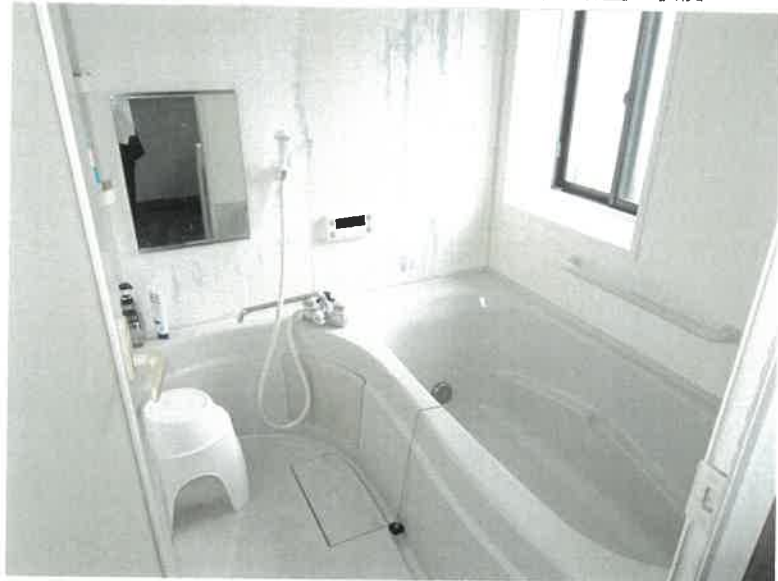
物件4 1階 浴室状況
