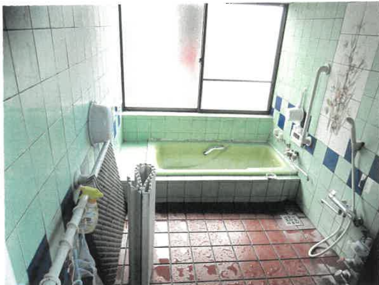
物件2主である建物 1階 浴室の状況
