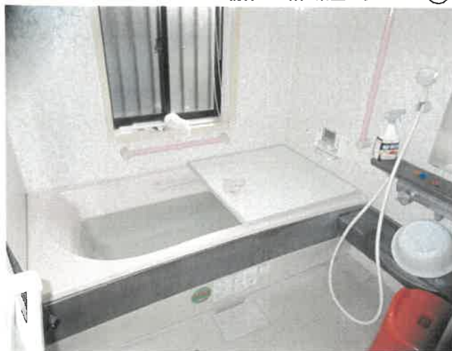
物件2 1階 浴室の状況 ⑦
