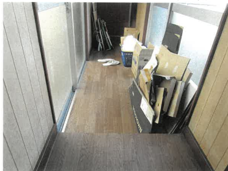
物件5未登記附属建物 渡り廊下の状況
