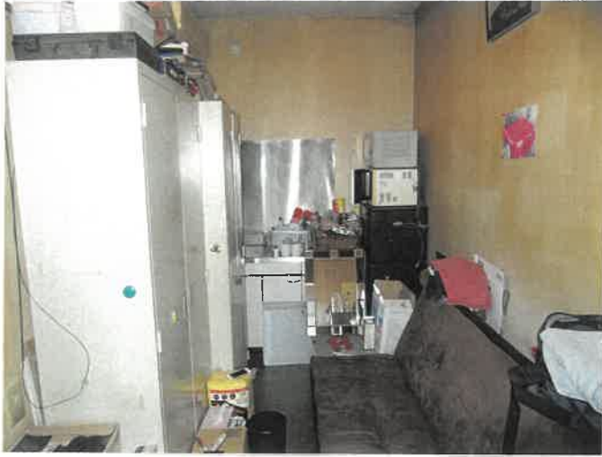
物件4 1階 休憩室の状況 ⑧
