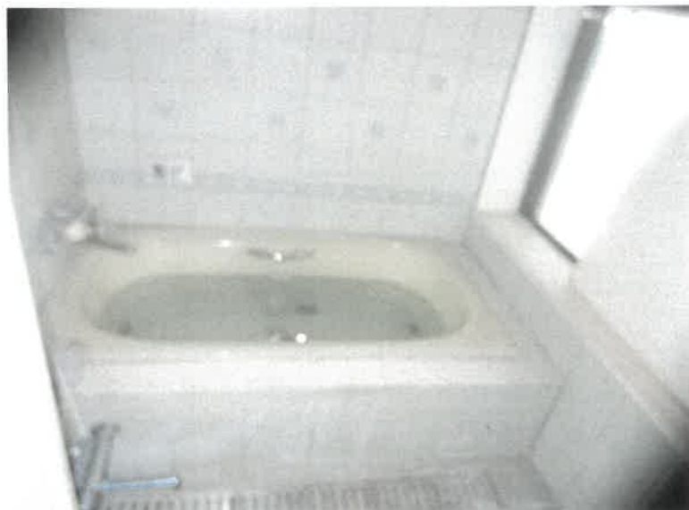
物件5主である建物 浴室の状況
