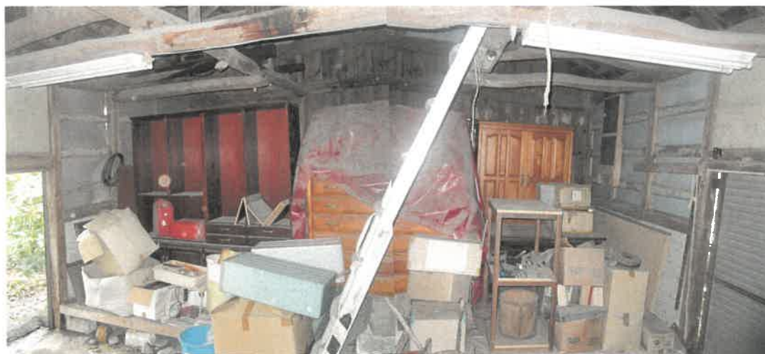
物件6未登記附属建物2 納屋の状況
