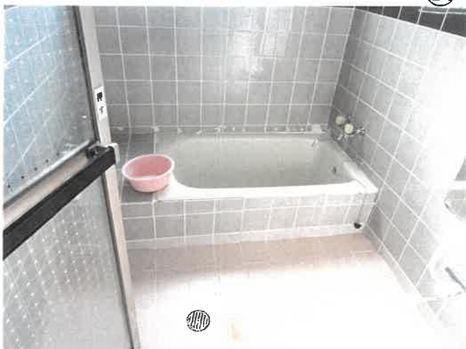
物件7 浴室の状況 ②④
