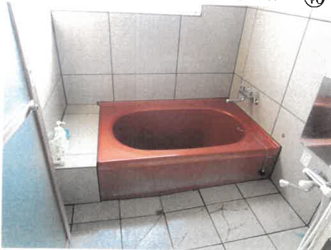
物件11 浴室の状況 ④⑩
