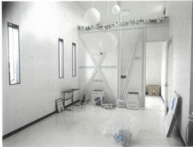
物件2 2階 リビングの状況
