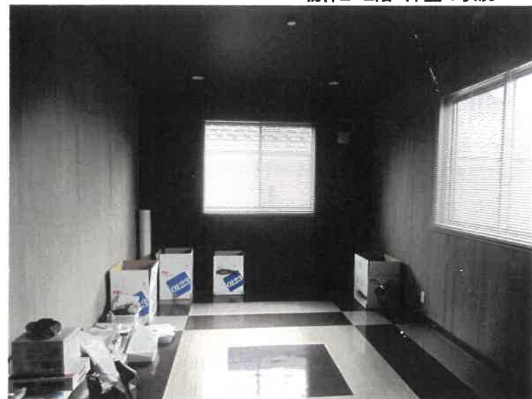
物件2 2階 洋室の状況
