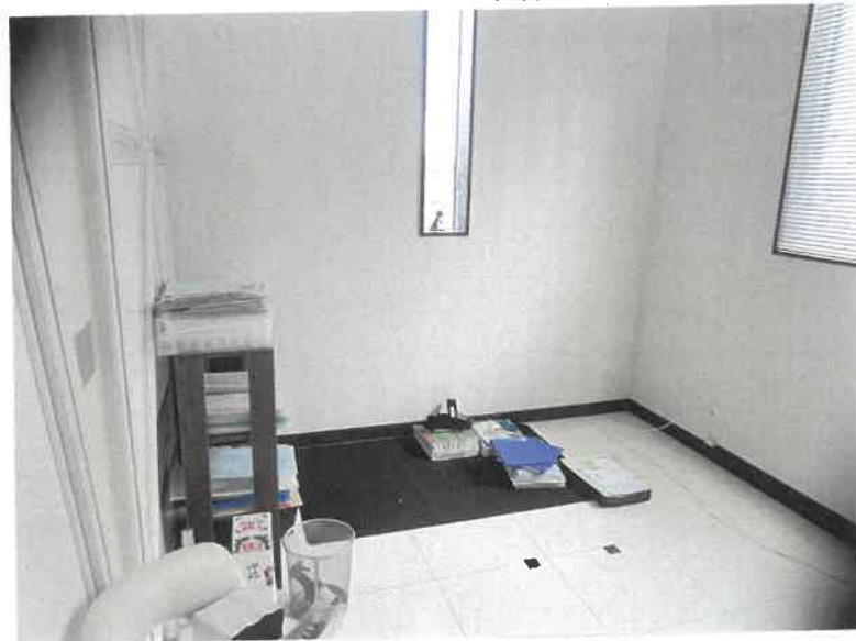
物件2 2階 洋室の状況
