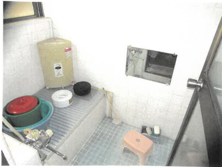
物件2主である建物 1階 浴室の状況
