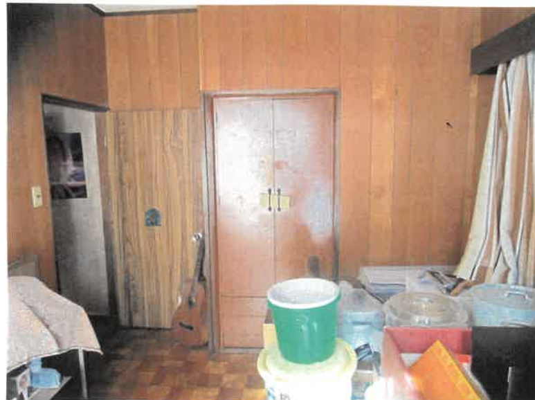
物件2主である建物 2階 洋室の状況
